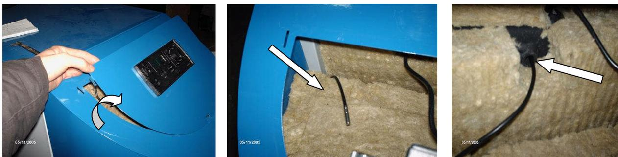
Bild 7, 8, 9. Nehmen Sie das Frontpanel ab. Ziehen Sie den Fühler heraus und schieben Sie den Fühler bis zum Anschlag in die Tauchhülse. Decken Sie dann die Tauchhülse z.B. mit einem Stück Alufolie ab, so dass der Fühler nicht herausfallen kann.
