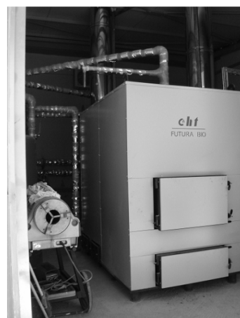
Futura Bio Pellets Kesselraum 3x350 kW in Griechenland
