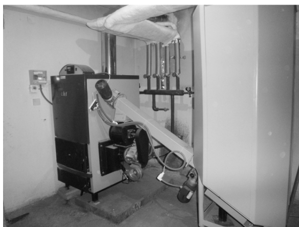
Futura Bio Pellets 50 kW Kesselraum in Griechenland
