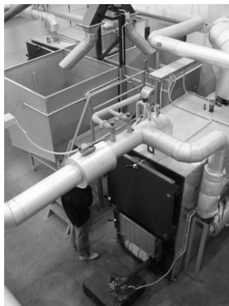
Futura Bio Pellet Wohnviertelkesselraum 2x350 kW in Litauen.
